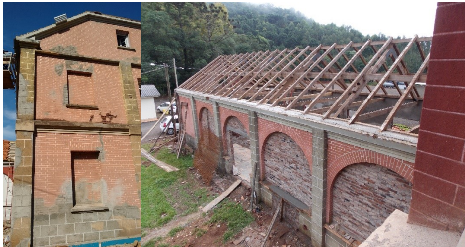
Casa Canônica durante as obras de restauro
