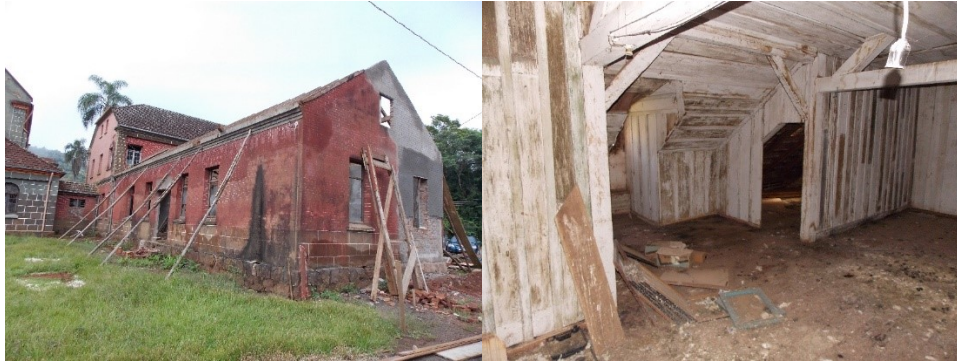
Casa Canônica antes e no início das obras de restauro
